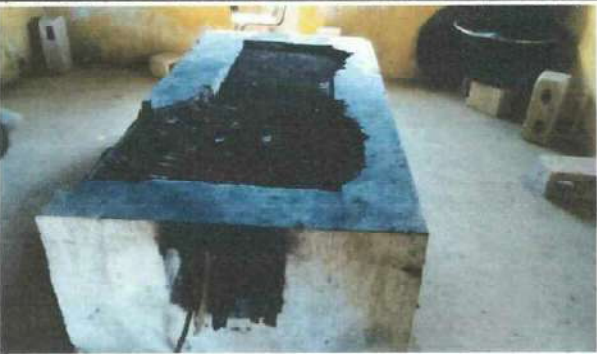
Foto 5: Remozamiento en área de cocina con sustitución de estufa rural que incluye chimenea y plancha de metal.
